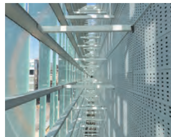
Double Peau Architecte : Marc BARANI
